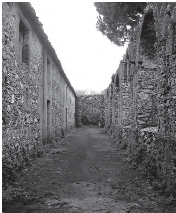
Cortile interno del Convento Agostiano
