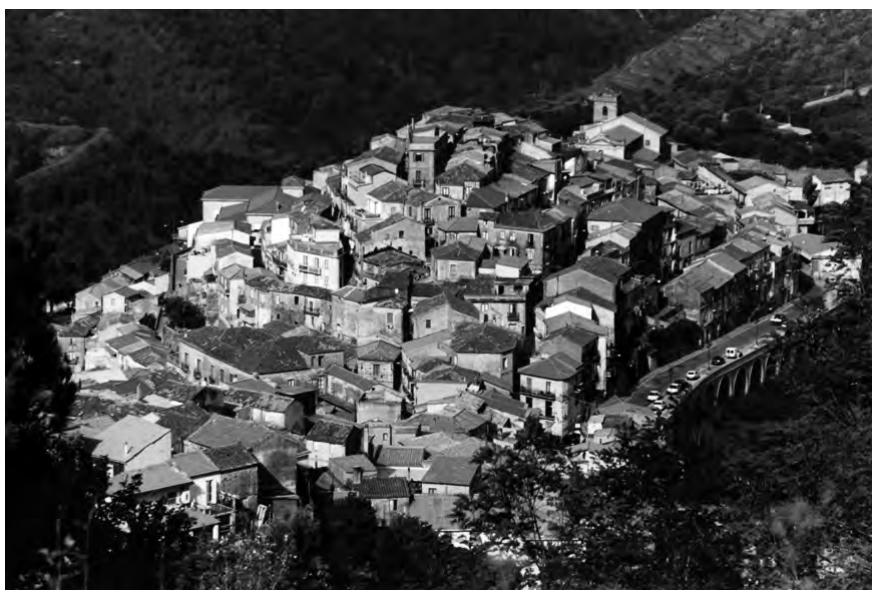
Monterosso Calabro, centro storico
