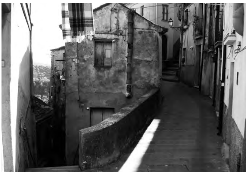
Monterosso Calabro - Centro storico
